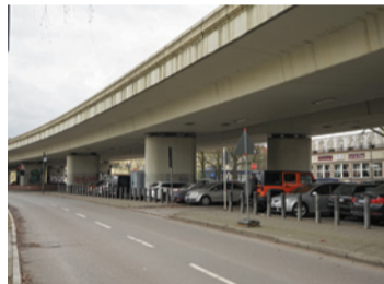
Der Rückbau der im Jahre 1978 fertiggestellten Autobahnbrücke über den Breitenbachplatz beginnt im Sommer
