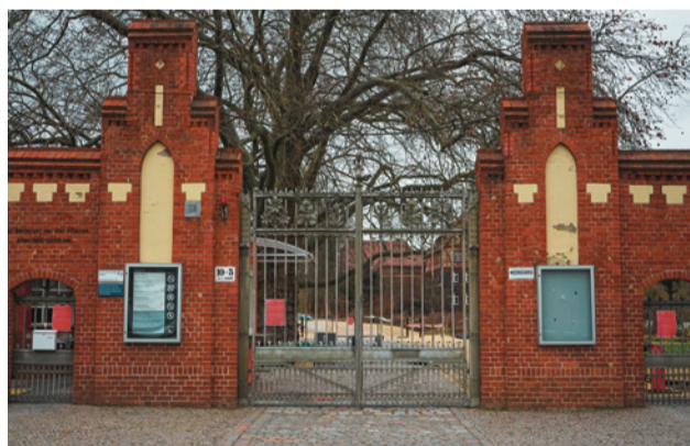
Ende März soll der Eingang „Unter den Eichen“ wieder für Besucher geöffnet werden
