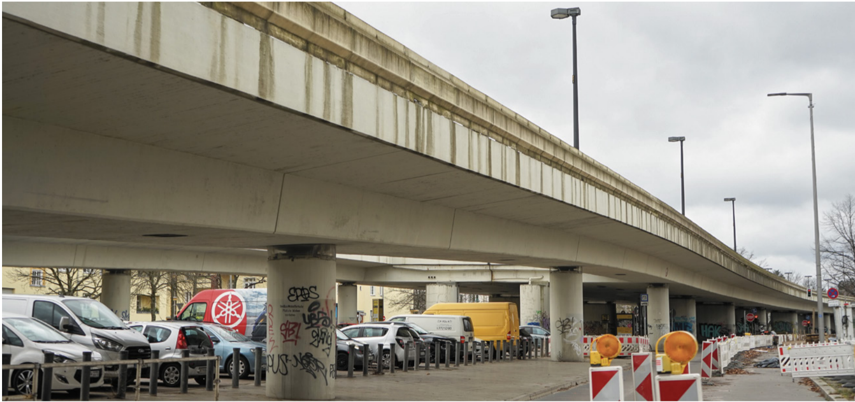
Die Brücke am Breitenbachplatz wird auch als „Mauer zu Dahlem“ bezeichnet Foto: Dr. Claudia Wein
